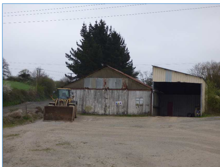
Fig. 8 : Photographie n°2 : Vue sur l'atelier et l'aire étanche abritée
