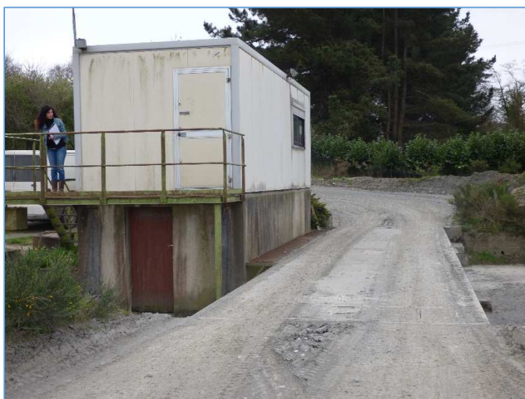
Fig. 7 : Photographie n°1 : Vue sur le bureau et pont bascule
